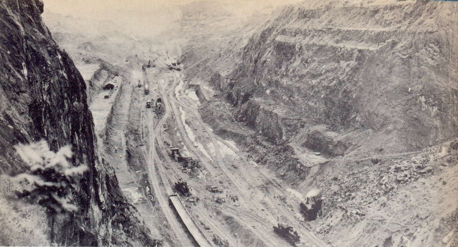
DE CULEBRA-DOORSNIJDING op de Landengte van Panama in 1913. Bergafschuivingen vormden een voortdurend probleem gedurende de hele constructie van het Panamakanaal. Meer dan 153 miljoen m 3 aarde werden er uitgegraven.
