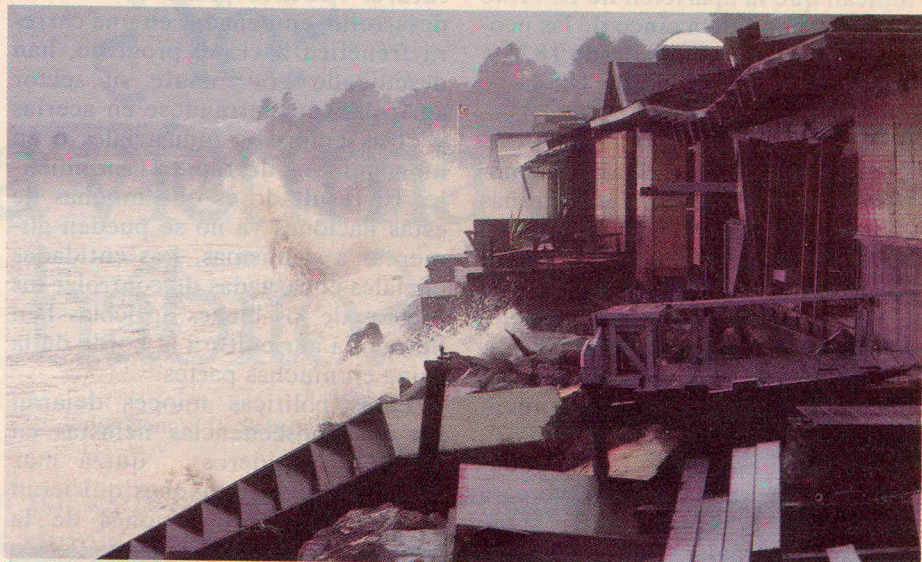
Se derrumban residencias en Santa Cruz, California
