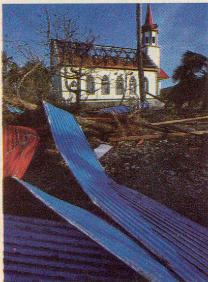
Daños causados en Tahití por el ciclón Veena
